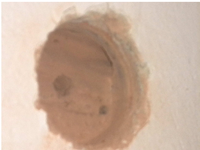
Obr. 1 – Sonda 2 – Korunkový vrt v keramické tvarovce
