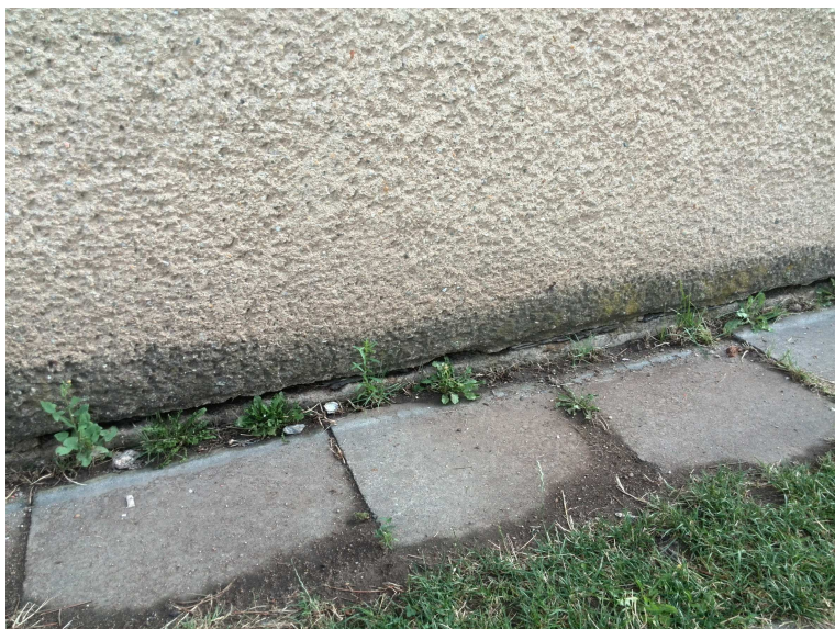
Obr. 2 – “Sonda” 5 – Návaznost základu na obvodovou stěnu
