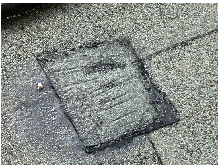
Obr.5 – Sonda 7 po zapravení
