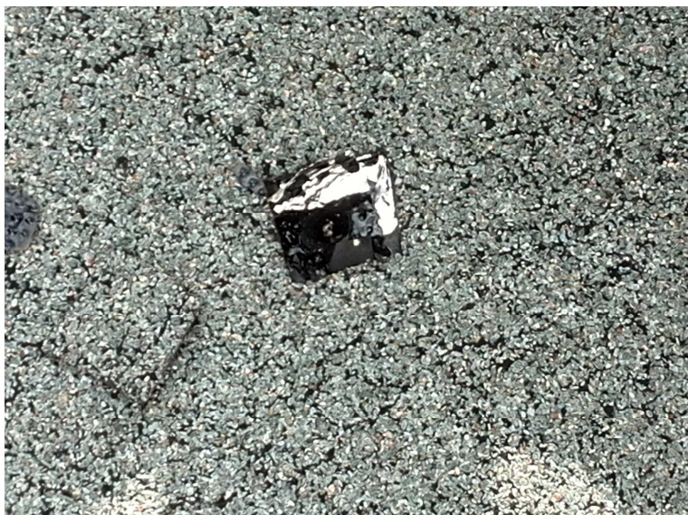
Obr. 4– Sonda 8 – Krytina s “bublinou“
